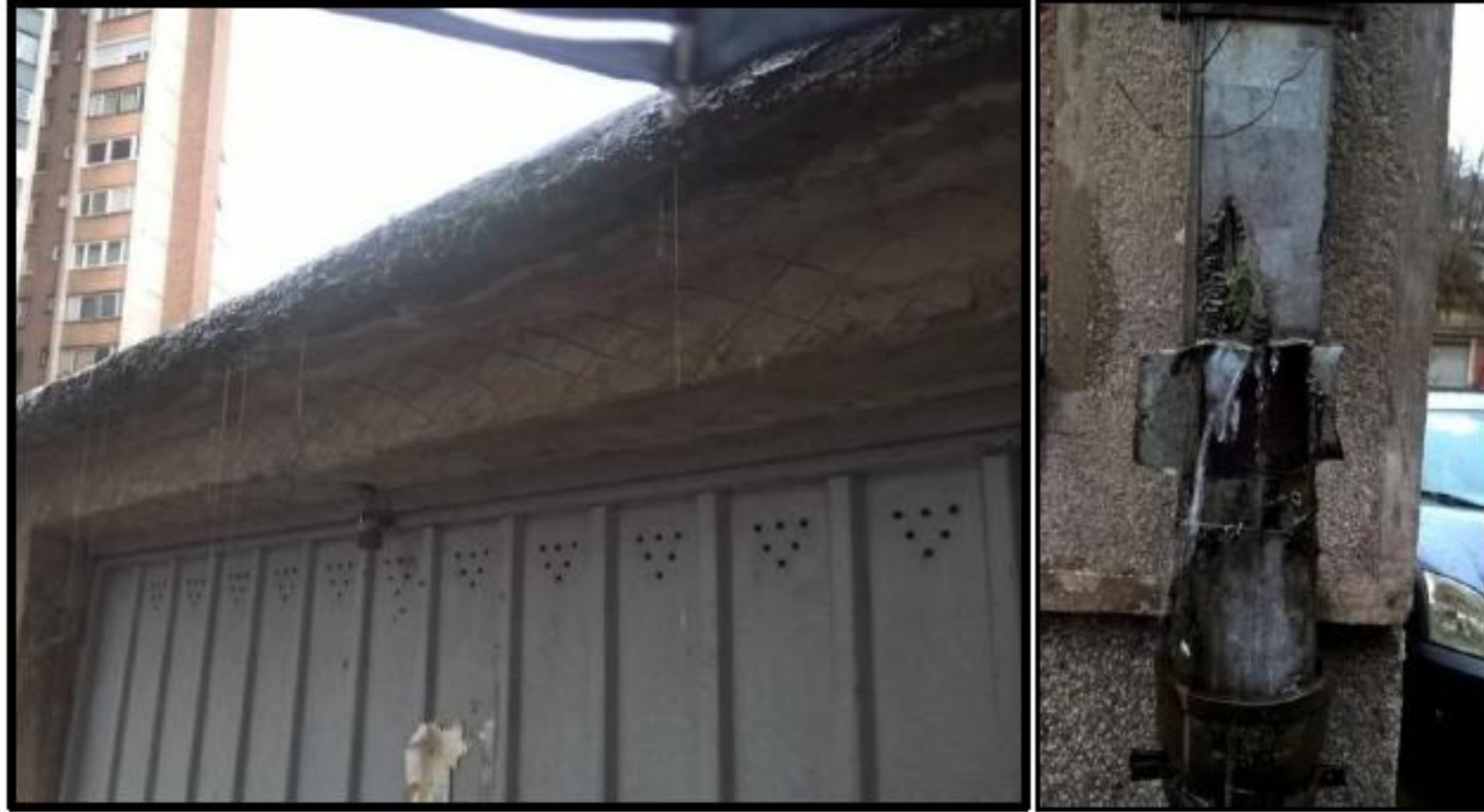
Slika 19. Oticanje oborinske vode sa površine konvenc. krova (lijevo) oticanje vode kroz oluk (desno)
