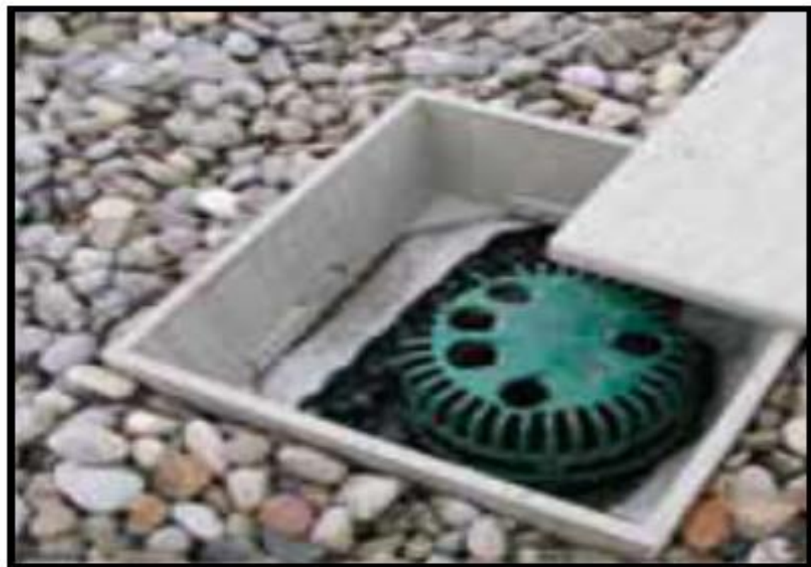
Slika 14. Rešetka za skupljanje vode (lijevo) i odvodni kanal /slivnik (desno) (Izvor: Diadem- izvođačka rješenja)
