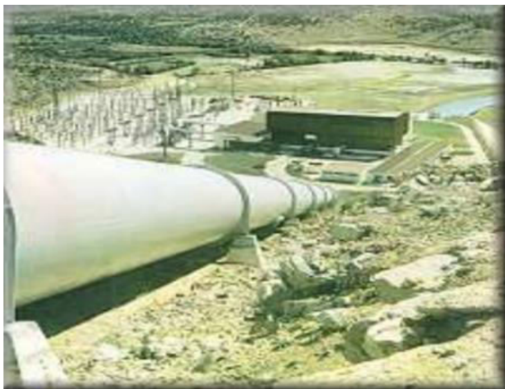
Derivaciona HE Velebit na rijeci Zrmanji, Hrvatska, instalirana snaga 276 MW
