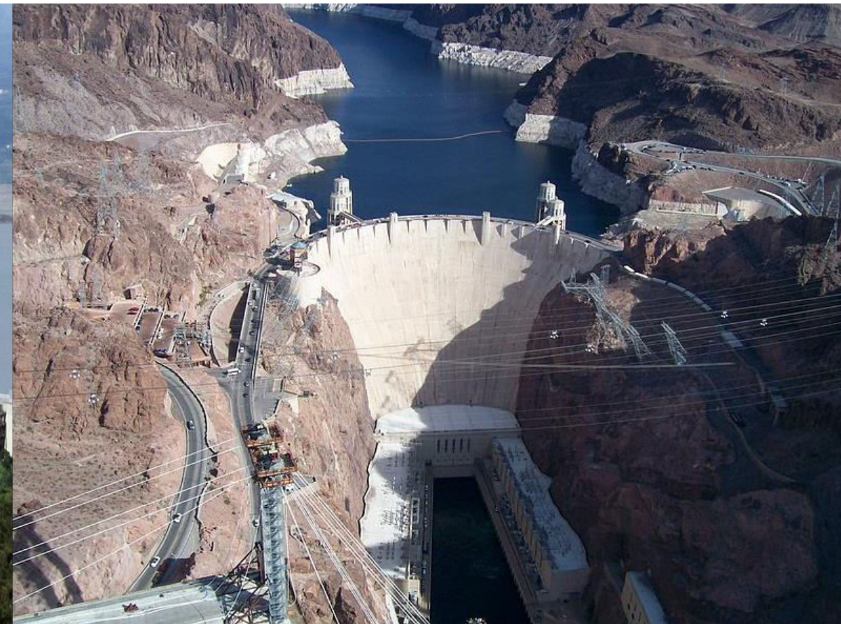
Hoover-ova brana na rijeci Colorado (USA) Instalisana snaga HE – 2080 MW
